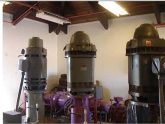
Effluent Pumps
