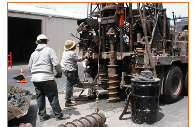
Instalación de un pozo de monitoreo de agua subterránea en Romic.
