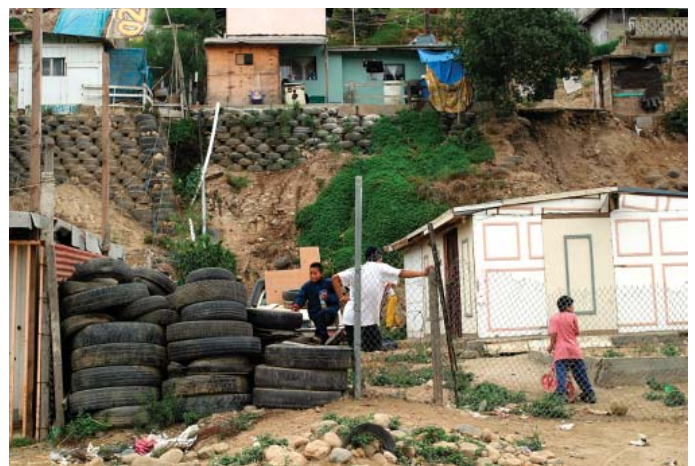
Llantas de desecho utilizadas como cimientos de viviendas informales, Cañón Los Laureles, Tijuana. ©Paul Ganster
