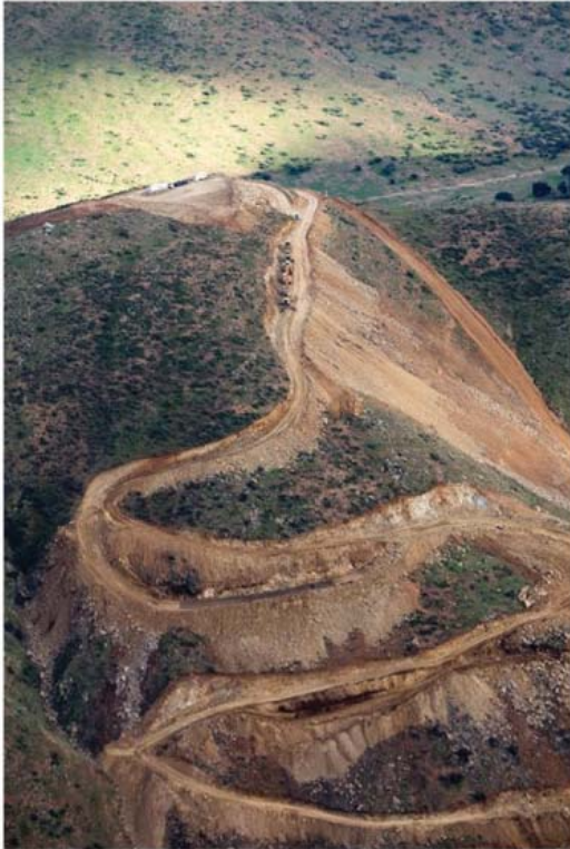
Foto 1: Construcción de caminos de acceso para la maquinaria de construcción del cerco fronterizo. Área silvestre de la Montaña Otay. Enero de 2009.
