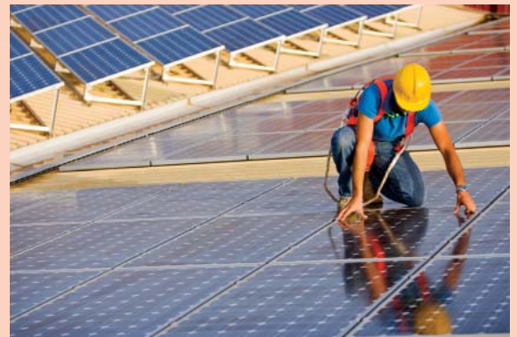
Trabajador inspecciona una instalación fotovoltaica. ©Pedro CastellanolliStockphoto
