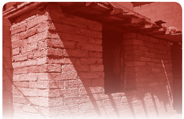
Vivienda de dos recámaras en proceso de construcción, construida por el mismo habitante utilizando bloques de concreto fibroso en Nogales, Sonora.
