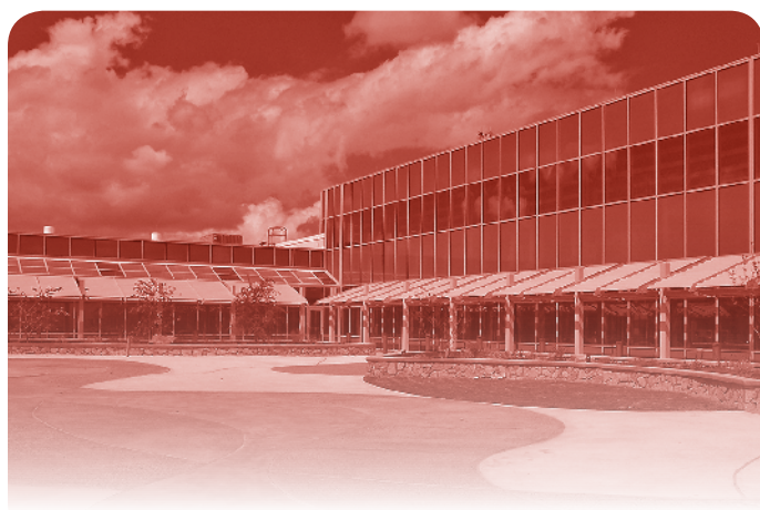
Kay Bailey Hutchison Desalination Plant, El Paso.
