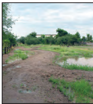
Este elevado sendero serpenteante funciona como una vereda que retiene el escurrimiento de aguas pluviales cerca del río Santa Cruz, al sur de Arizona.
