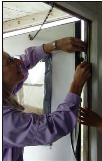
Un contratista de Viva Verde instala material aislante en el marco de la puerta de una casa del sur de Nuevo México.
