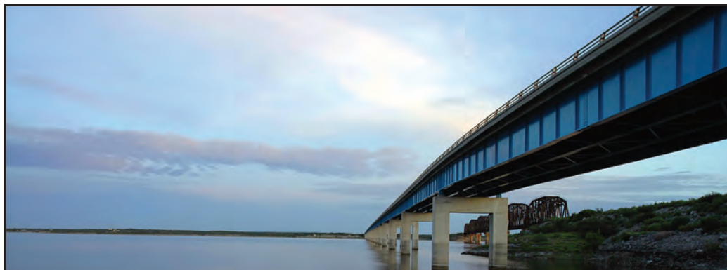
Un puente sobre la Represa Amistad, ubicado aguas arriba de las ciudades hermanas fronterizas de Del Río-Ciudad Acuña, es un ejemplo de infraestructura vital para la preparación y respuesta a emergencias transfronterizas.
