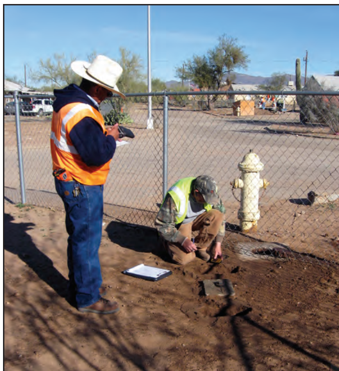
Trabajadores de servicios públicos en Sells, Arizona, determinan la ubicación de la red principal de agua, práctica conocida como "espeleología".
