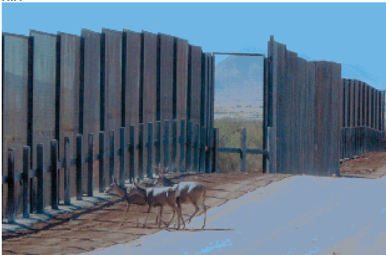
Foto 6: Venados Mula acercándose al cerco fronterizo en la región de San Pedro en el sureste de Arizona. 2008.
