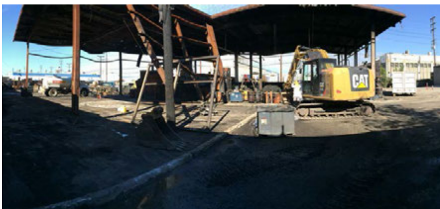
Vista desde el sur y centro del sitio antes del retiro de deshechos (7 de Noviembre) y hoy (30 de Noviembre, 2016)
