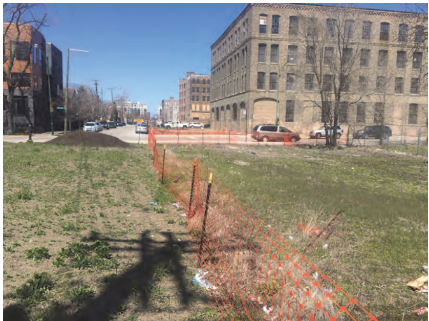
Este cercado fue instalado para impedir el acceso a las zonas contaminadas. BNSF instalará una valla temporal en las áreas de excavación.
