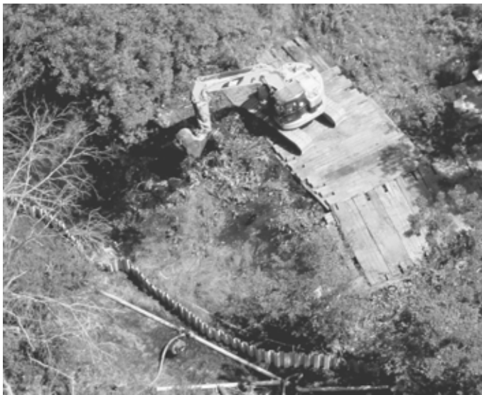
Se construyen caminos temporeros y plataformas que permiten el uso de equipo pesado para excavar el suelo contaminado con petróleo a lo largo del río de Kalamazoo.
