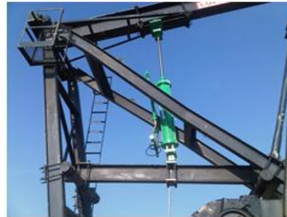
Pozo Llanito 114, Montaje tipo Samson .
